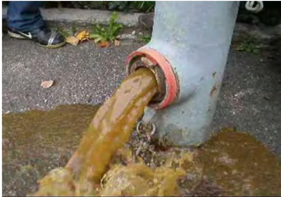
Der Betrieb nach dem DVGW Regelwerk W 331 – eine Kontrolle auf Komplettentleerung des Hydranten kann in diesem Einbausituation nicht erfolgen!
