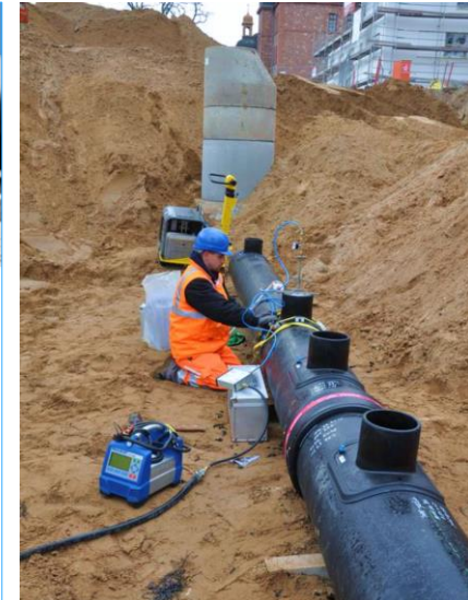
Darstellung: Heizwendelschweißen, Dokumentation via FRIATRACE Software Quelle: friatec.de, Abruf: 27.01.2019 / Screenshot Desktop Anwendung
